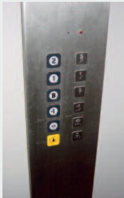
Deze liftknoppen zijn naast goed leesbare cijfers met zowel reliëf als braille uitgevoerd
