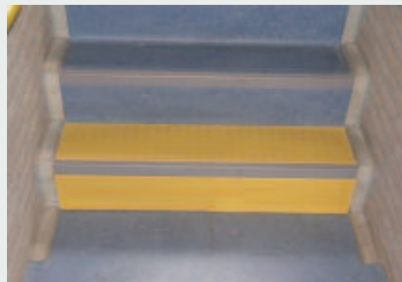
De onderste traprede is gemarkeerd met een afwijkende kleur en een noppenprofiel
