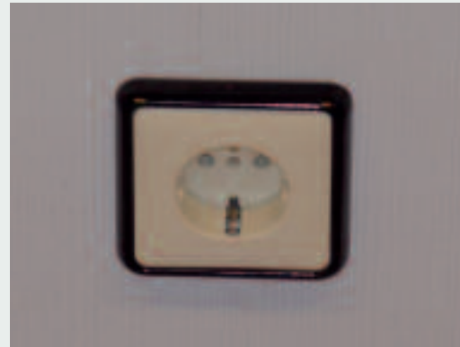
Goed zichtbare wandcontactdoos met contrasterende kleuren (zwart afdekraam).
